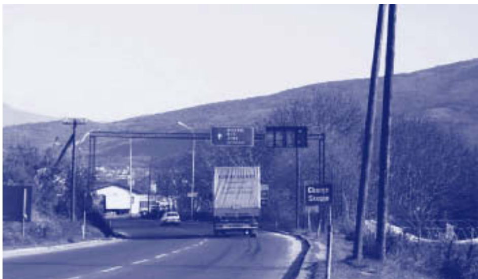
Remise en état des routes, ARYM
